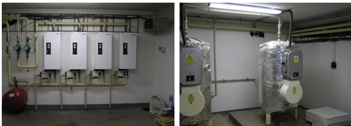
obrázek 3 Elektrokotle v kotelně lůžkového pavilonu a stacionární zásobníkové ohřivače v elektrokotelně 3
